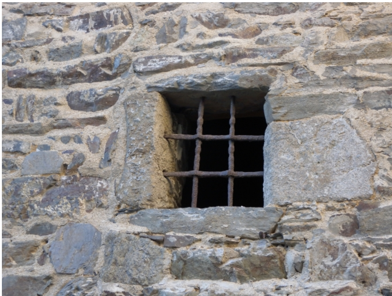
Vue de détail d'une ouverture avec grille en fer forgé, datée du 15ème, rue des Frères Durand
