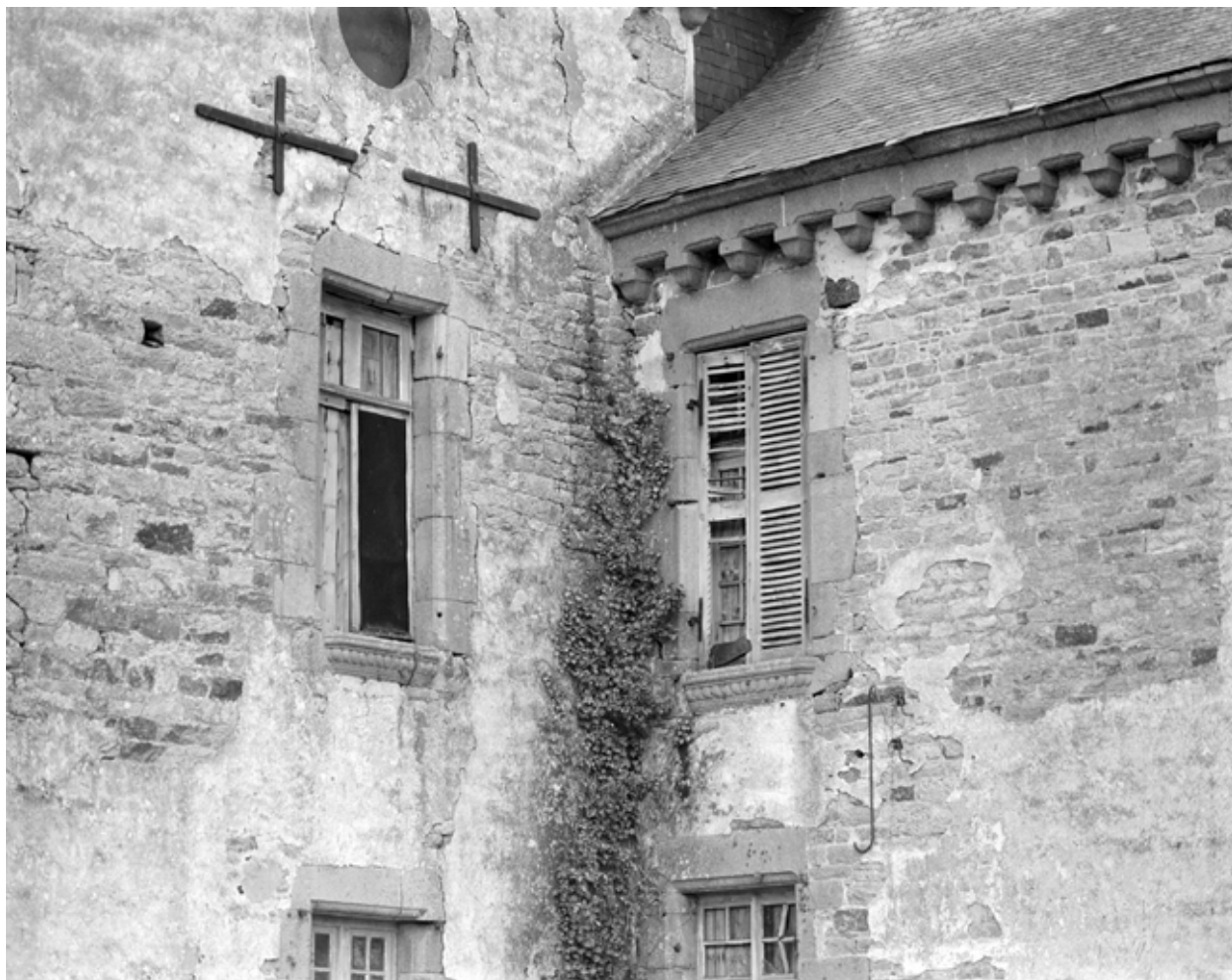
Logis, face ouest : détail fenêtre
