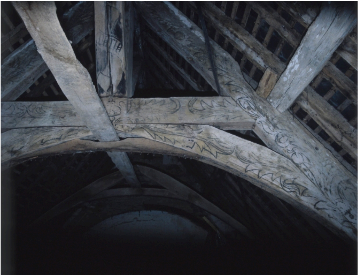
Détail sous charpente.
