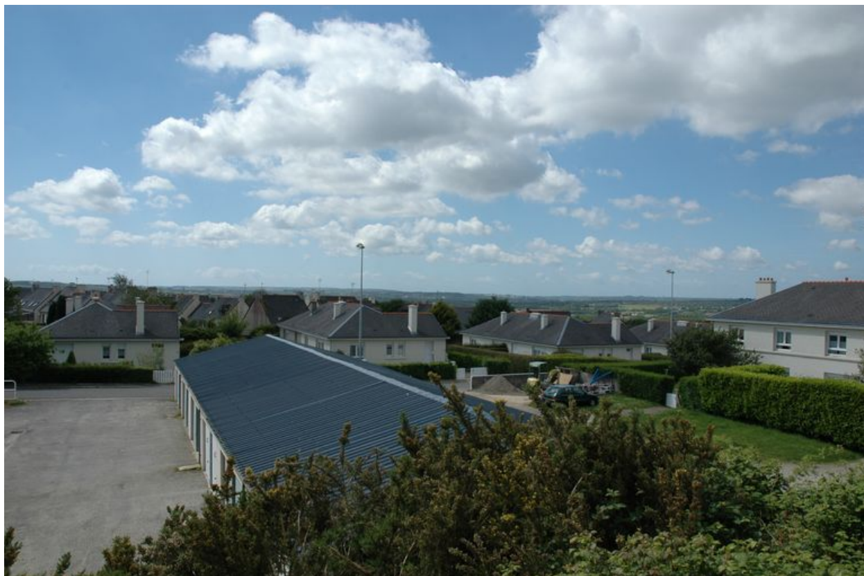
Vue du panorama vers le nord-ouest depuis le parc de Keranroux (état en 2007)
