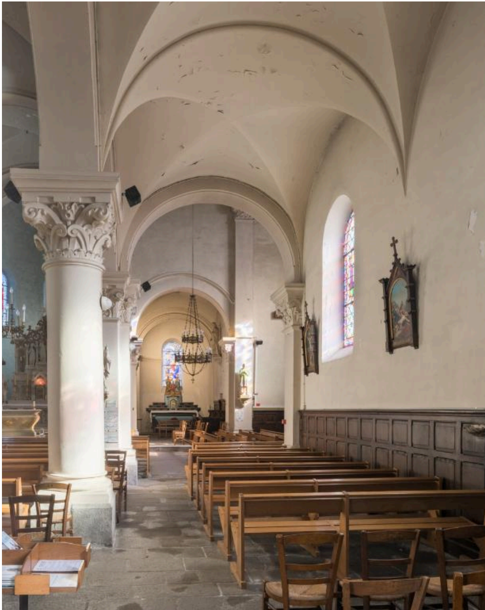
Vue générale du bas-côté sud
