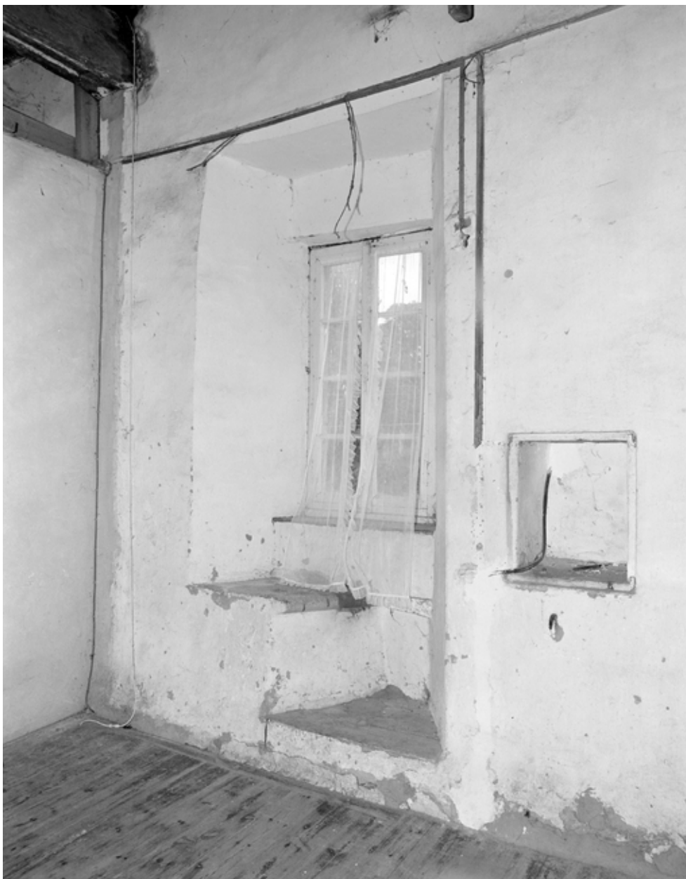
Etage du logis, mur sud du palier, fenêtre à coussiège. Etat en 1977.
