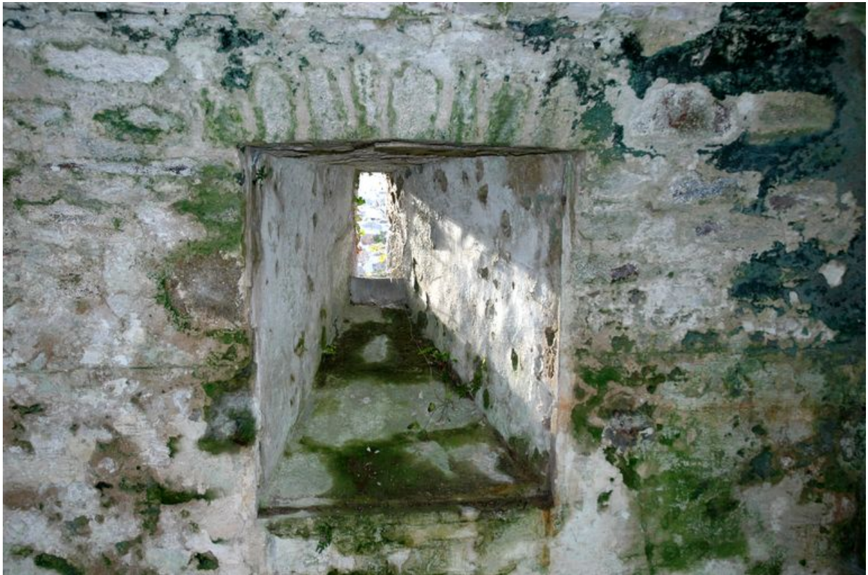
Vue intérieure : créneau de tir permettant la défense du fossé sec (état en 2004).
