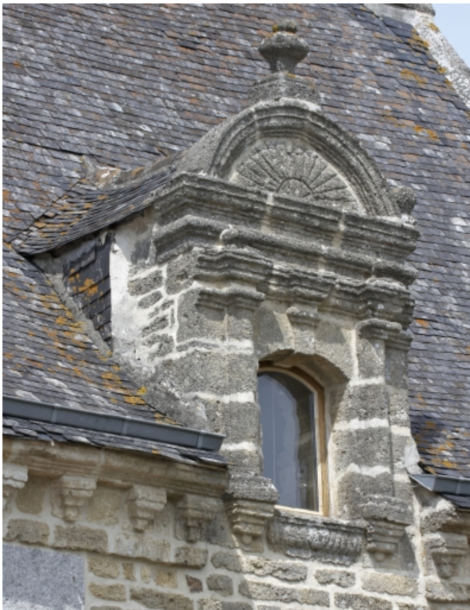
Détail : lucarne à fronton cintré, tympan avec décor gravé d'un soleil
