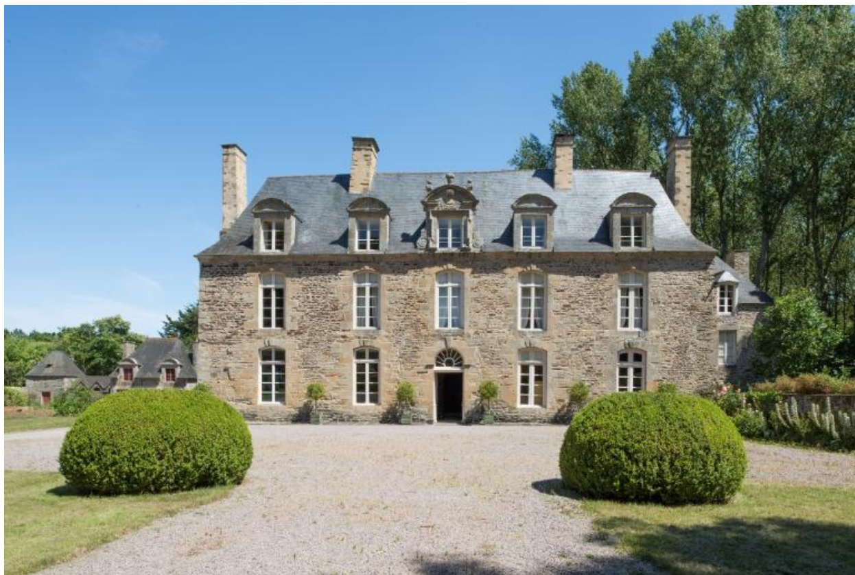
Vue d'ensemble, façade sud
