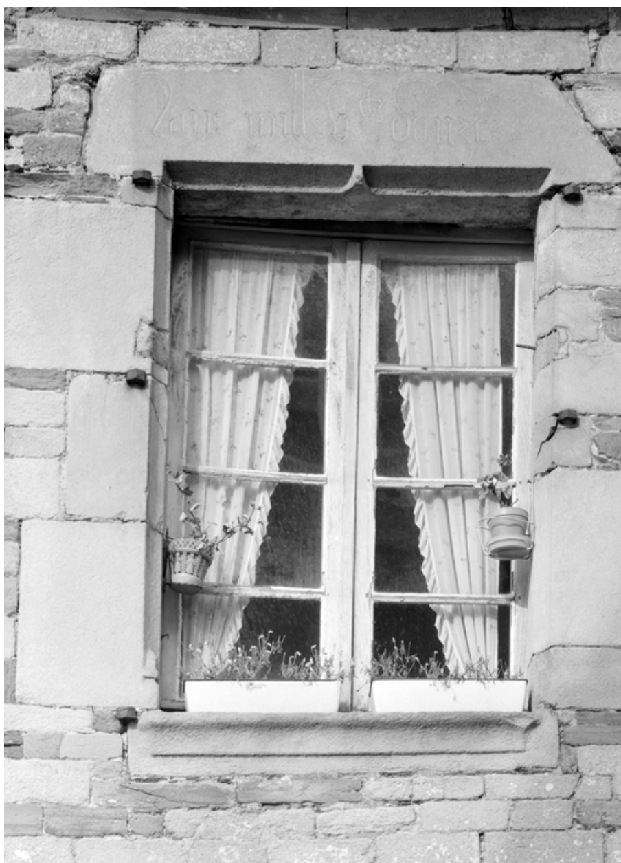
Fenêtre à inscription à l'est sur la façade sud-ouest.
