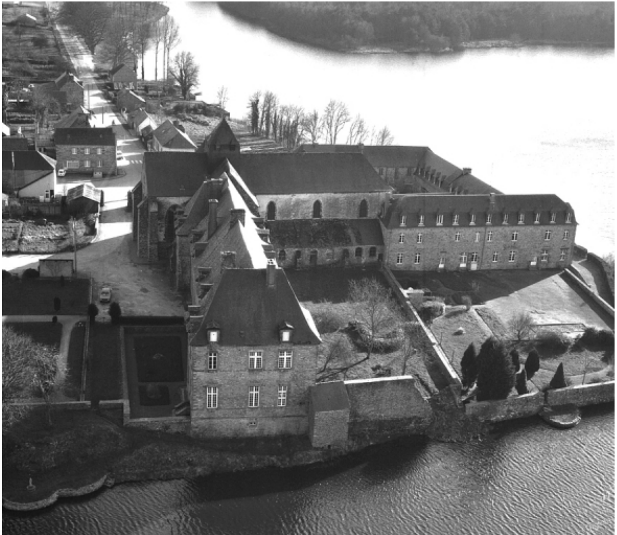
Vue aérienne nord
