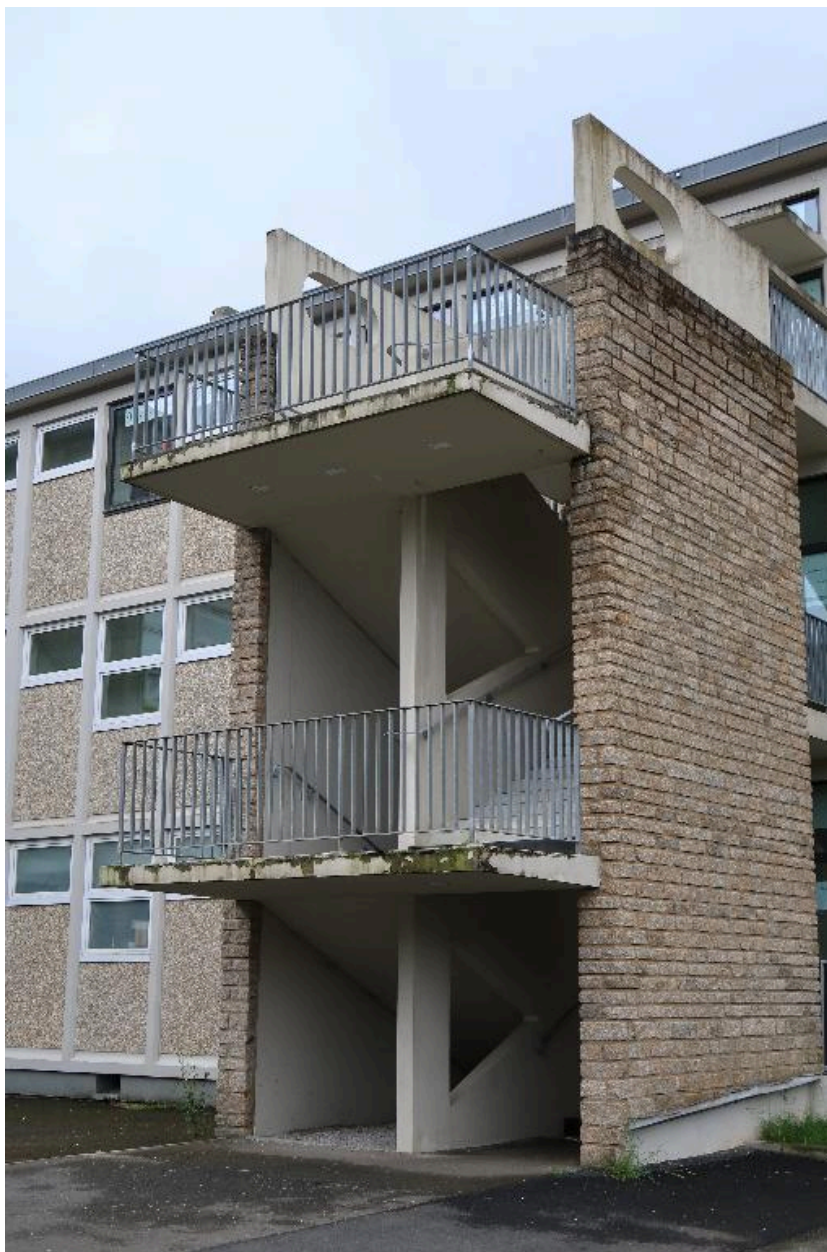
Escalier hors œuvre ajouré (bâtiment L).
