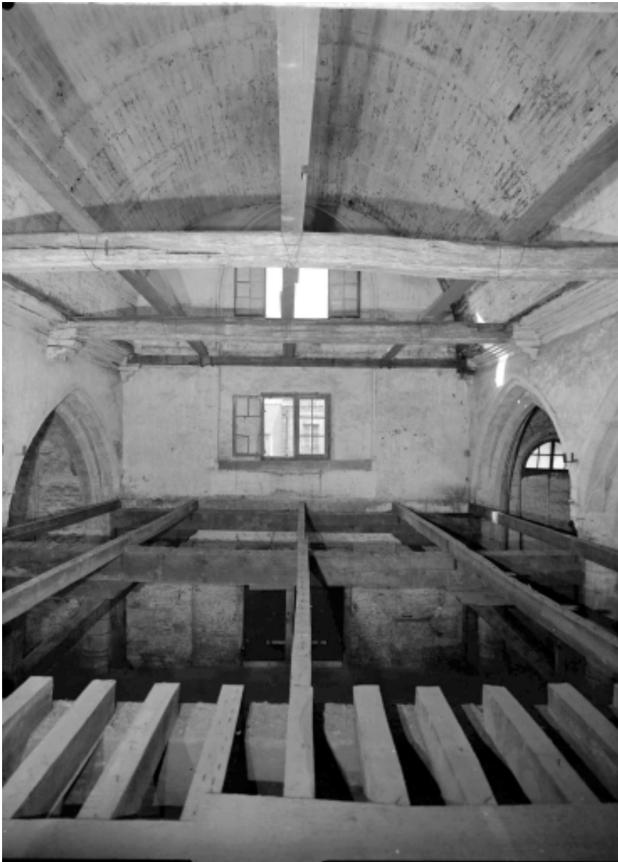
Charpente de la nef
