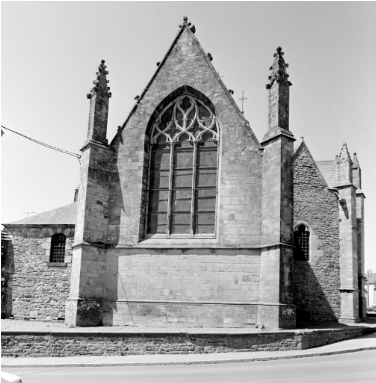
Vue générale angle de la rue.
