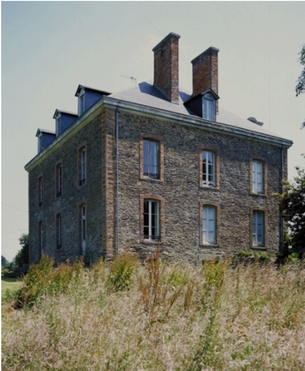
Pignon ouest : vue générale
