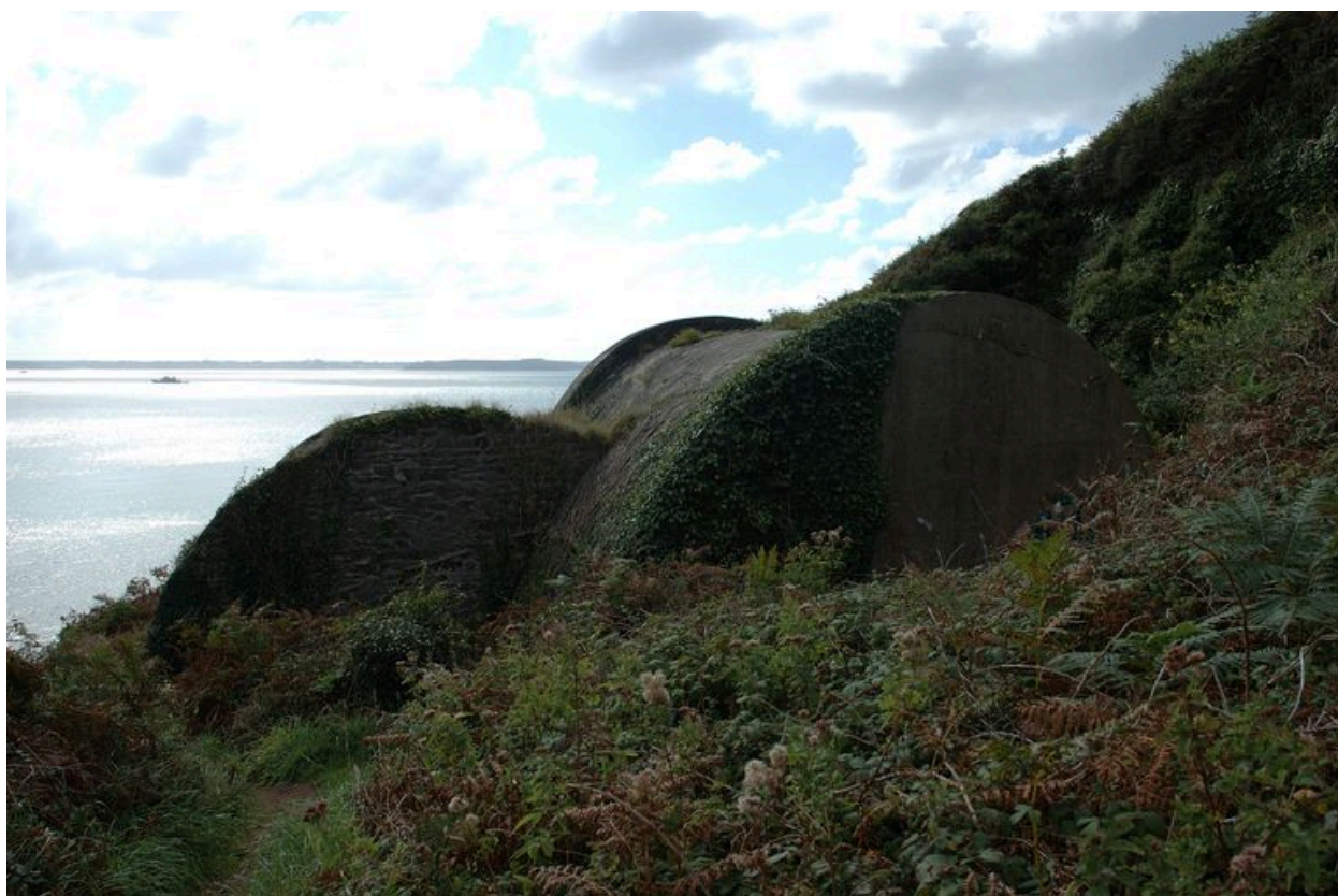
Vue des casemates de projecteur (état en 2007)
