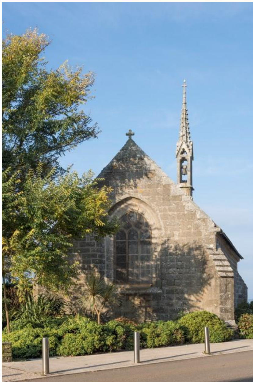
Chapelle Notre-Dame-de-Bon-Secours, élévation est
