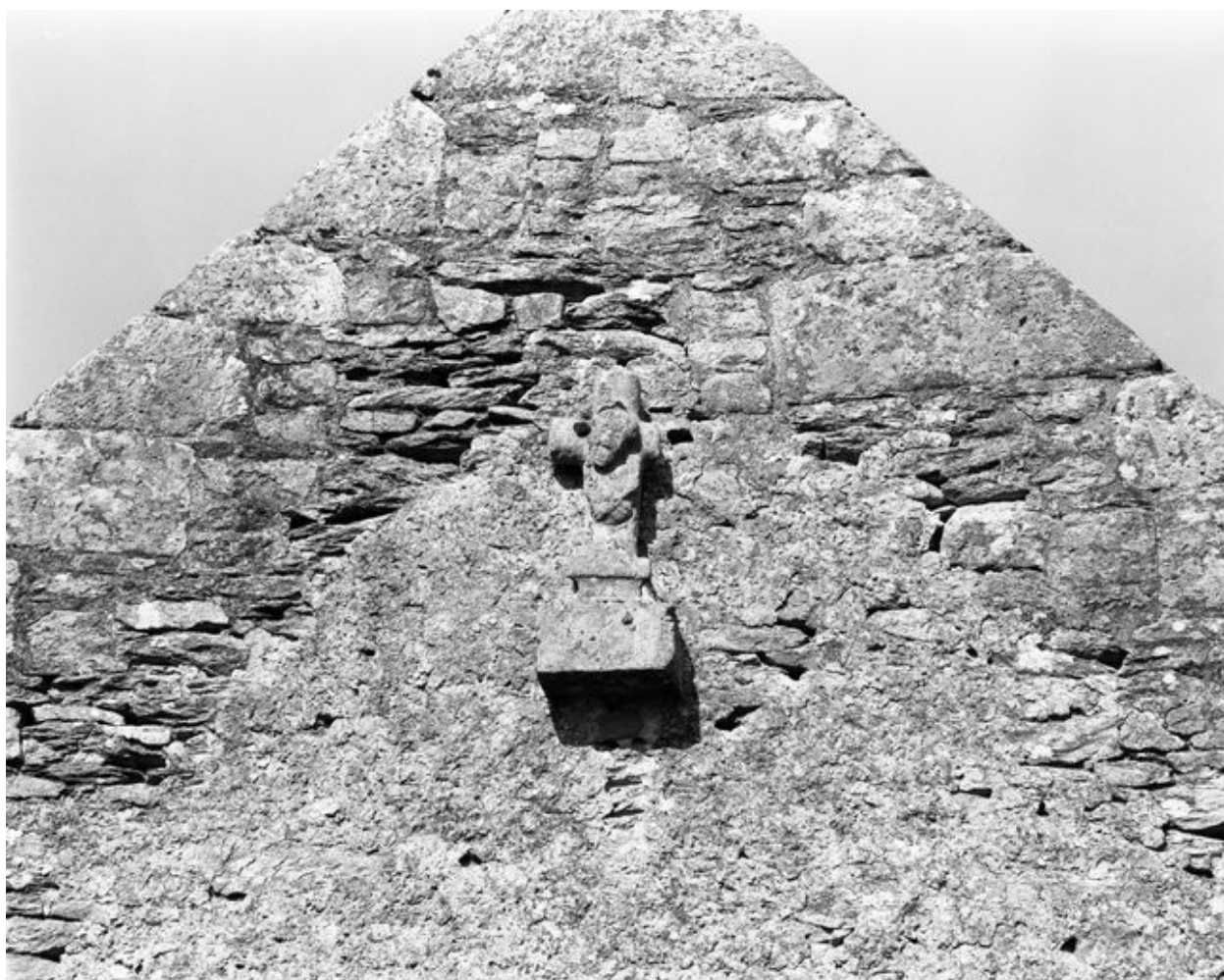
Chevet, partie supérieure : élément de Christ en croix remployé
