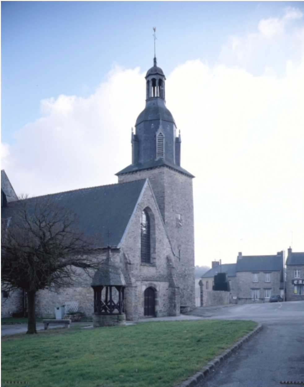
Elévation ouest : vue générale.
