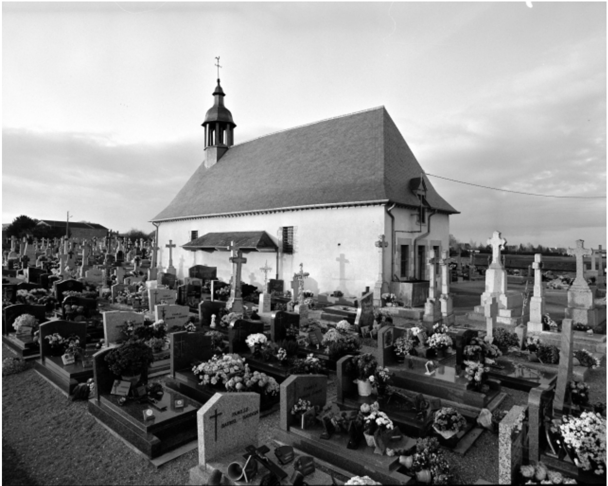
Elévation Sud-Est : vue générale
