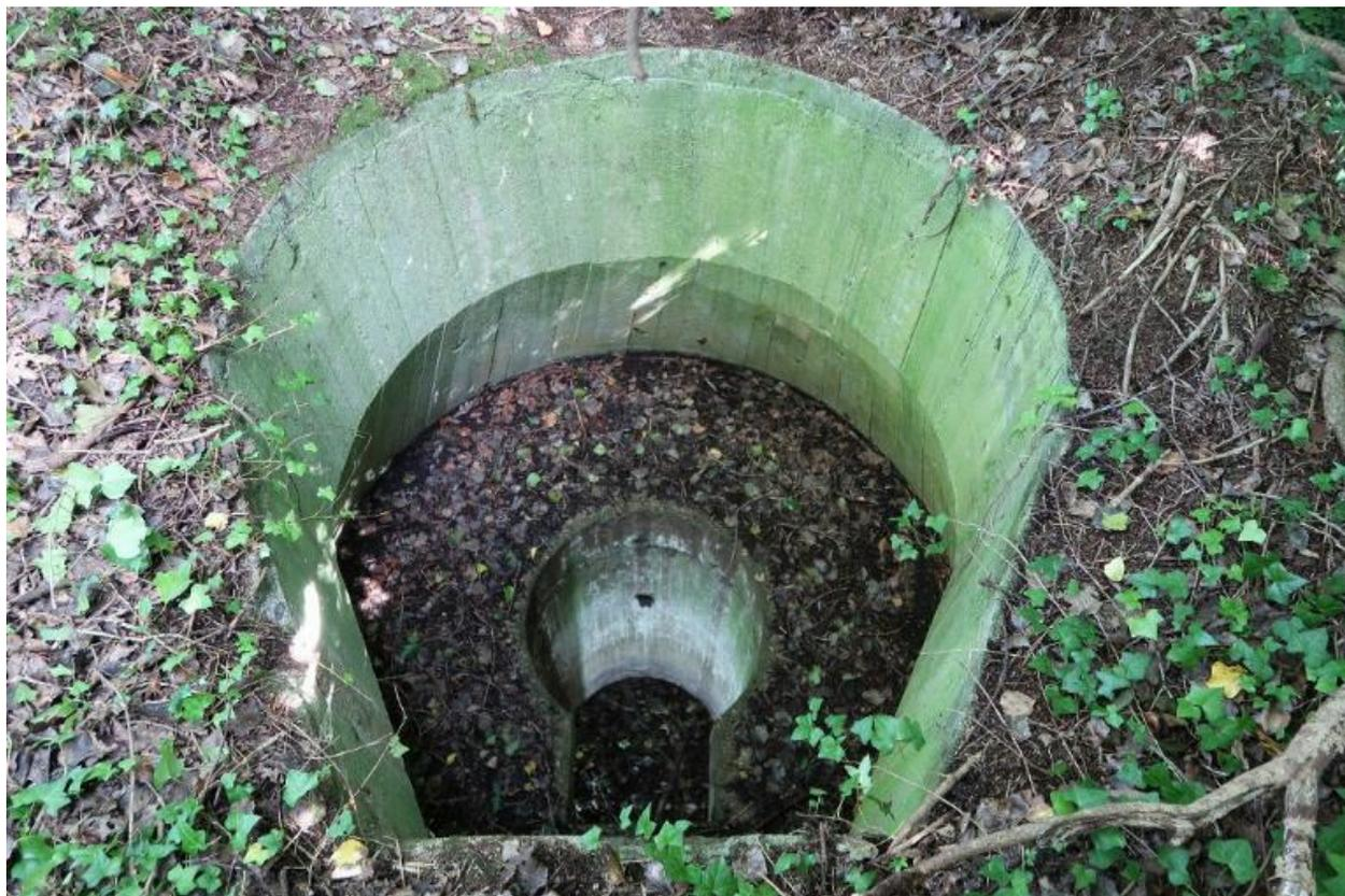
Vue de l'emplacement de la cloche blindée depuis l'extérieur. Ce bunker aurait dû être doté d'une cloche blindée de type 89P9
