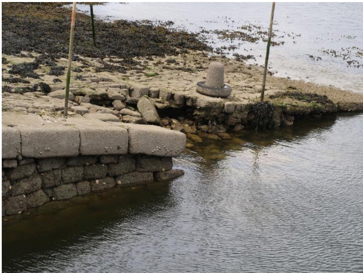
Ancien platin de carénage du môle Pénéroff
