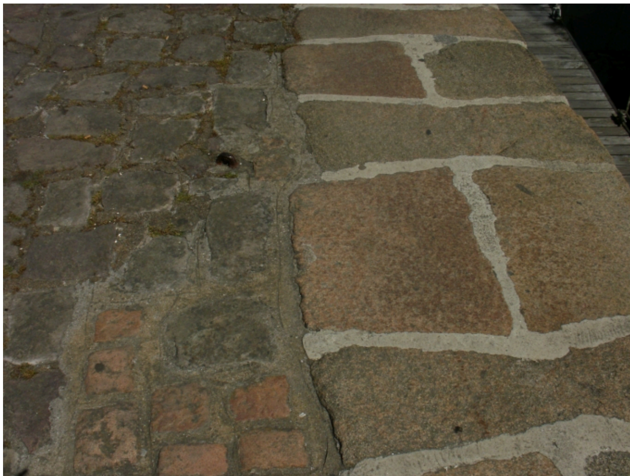
Vue de détail de la disposition des pierres de taille et des moellons de granite du Quai Loti
