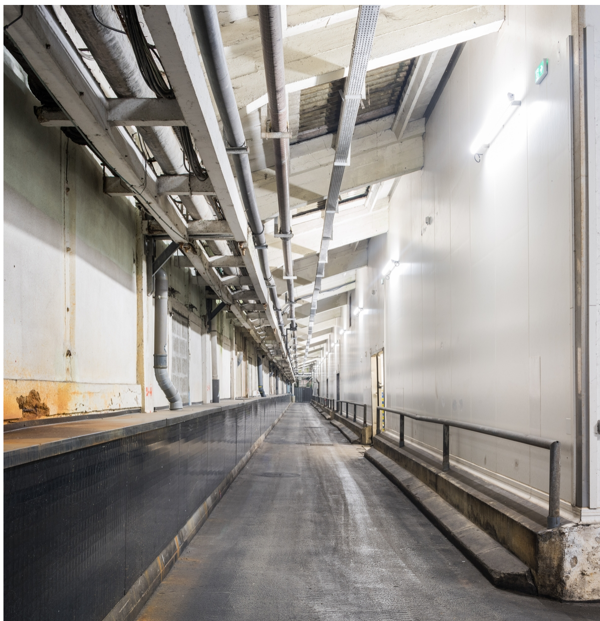
Zone de circulation de la criée à proximité du magasin à marée (criée 2)
