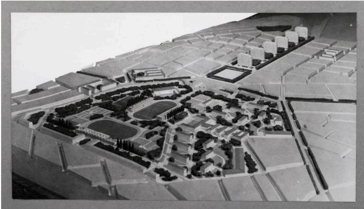
Maquette du projet de reconstruction de Lorient, "zone B". Au premier plan, le lycée. La partie centrale dite "la langouste" ne sera pas réalisée suite à une évolution du plan masse.
