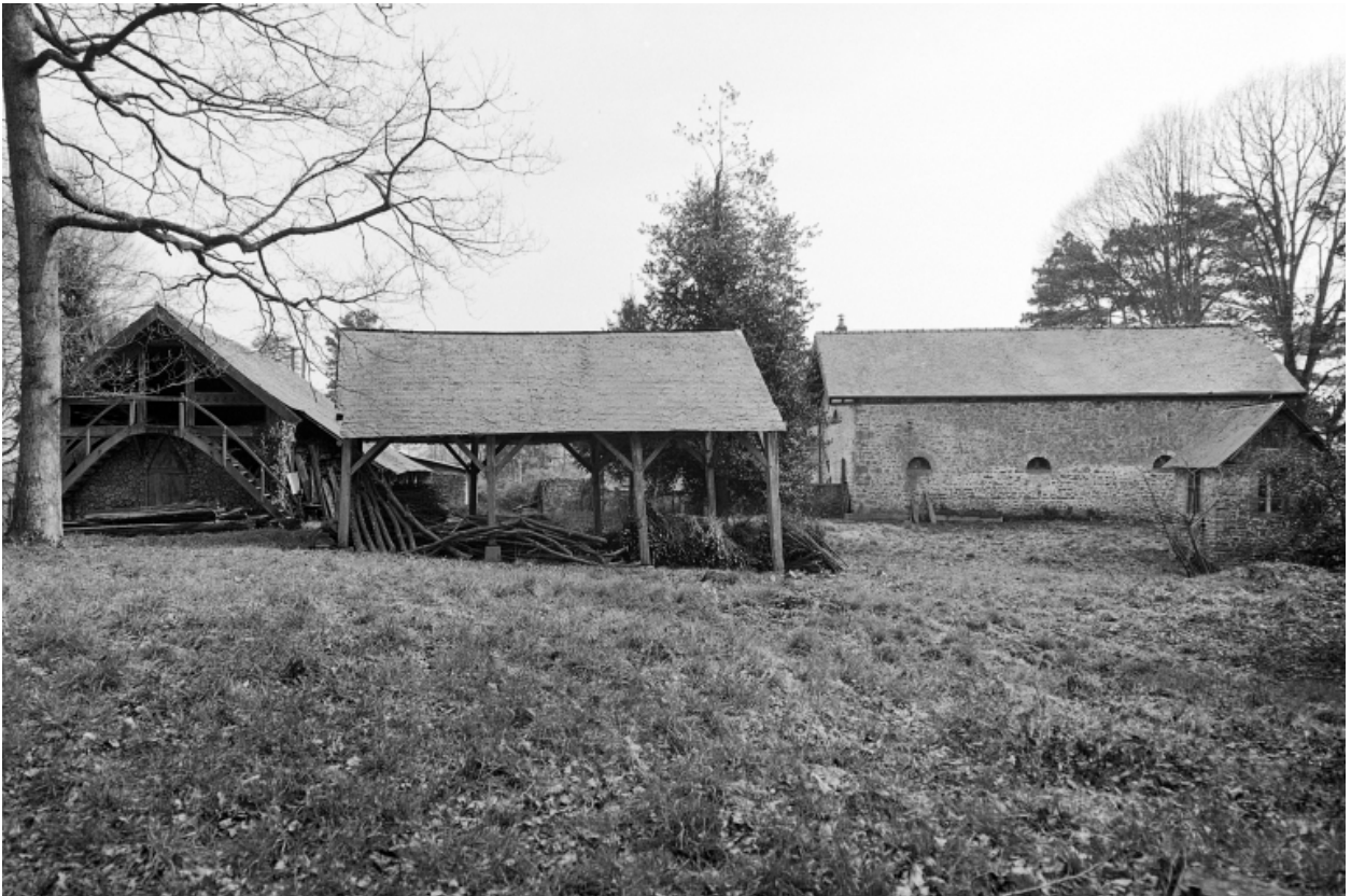
Dépendances, vue générale nord.
