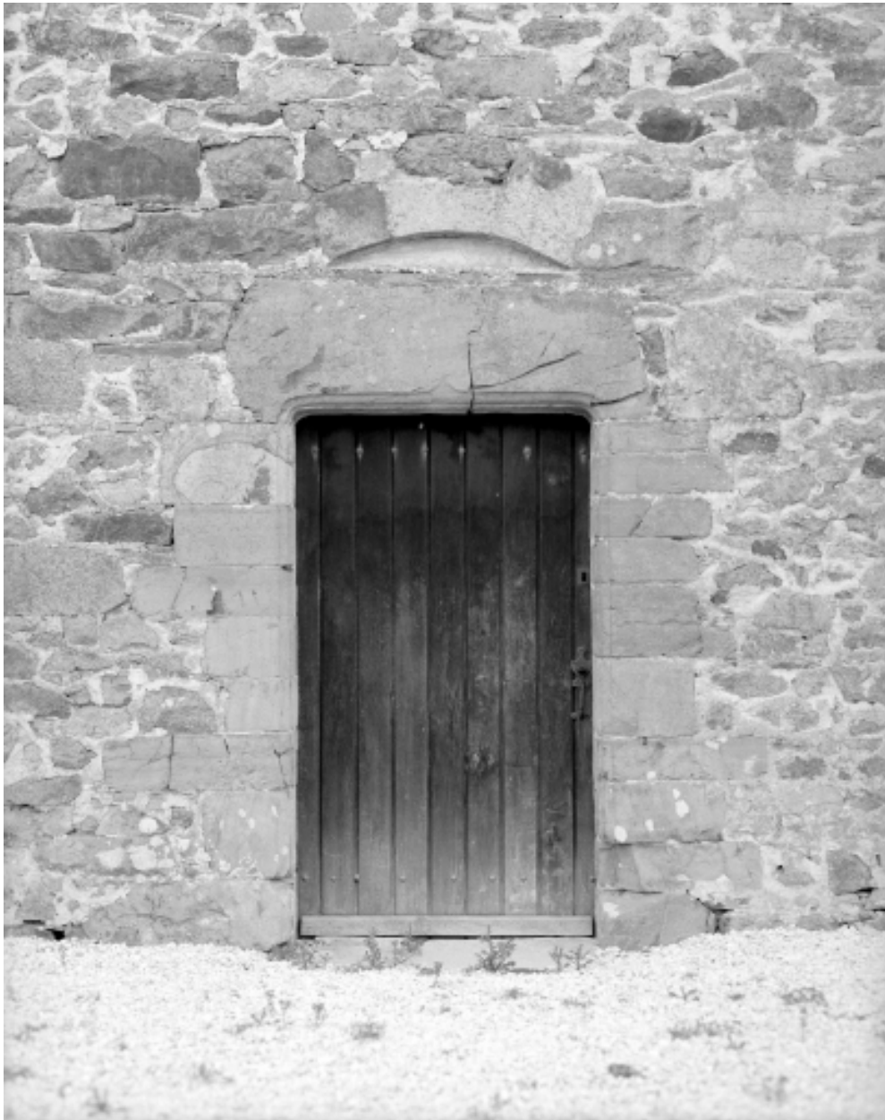
Elévation Sud, porte : vue générale
