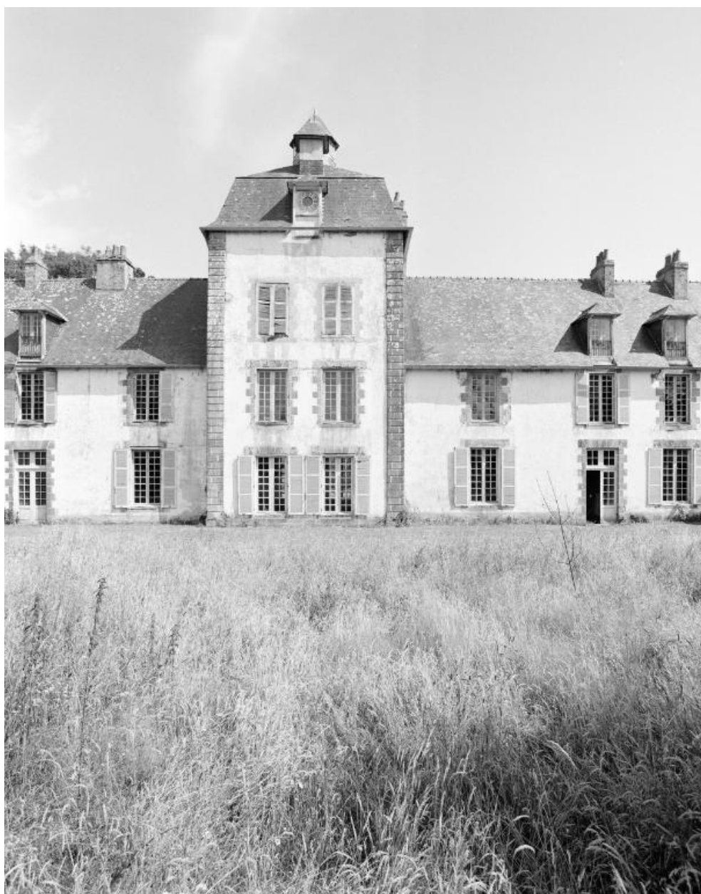
Elévation nord, pavillon central.
