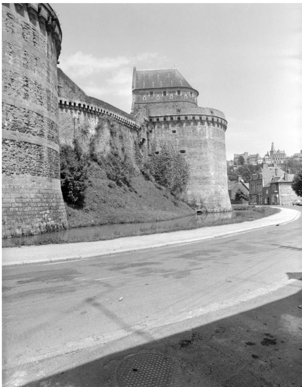
Tour Raoul, vue latérale ouest.
