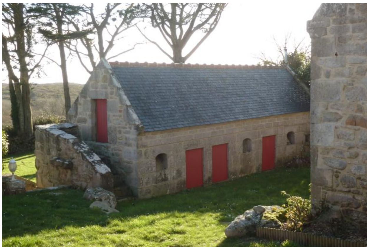
Ferme 1, crèches à cochons en pierres de taille, façade nord.
