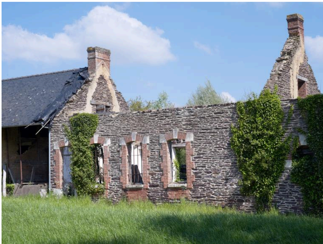
Façade est de la ferme
