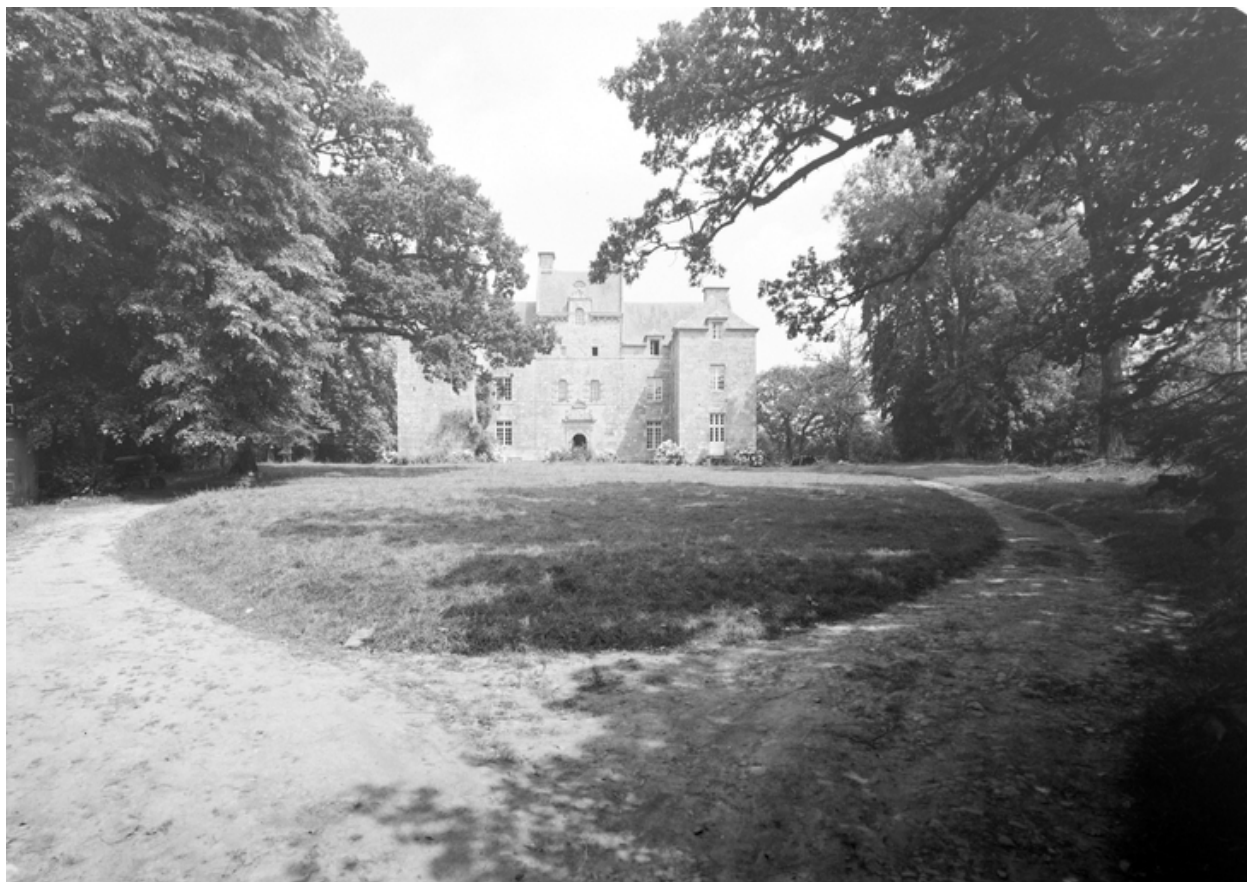
Vue de situation ouest
