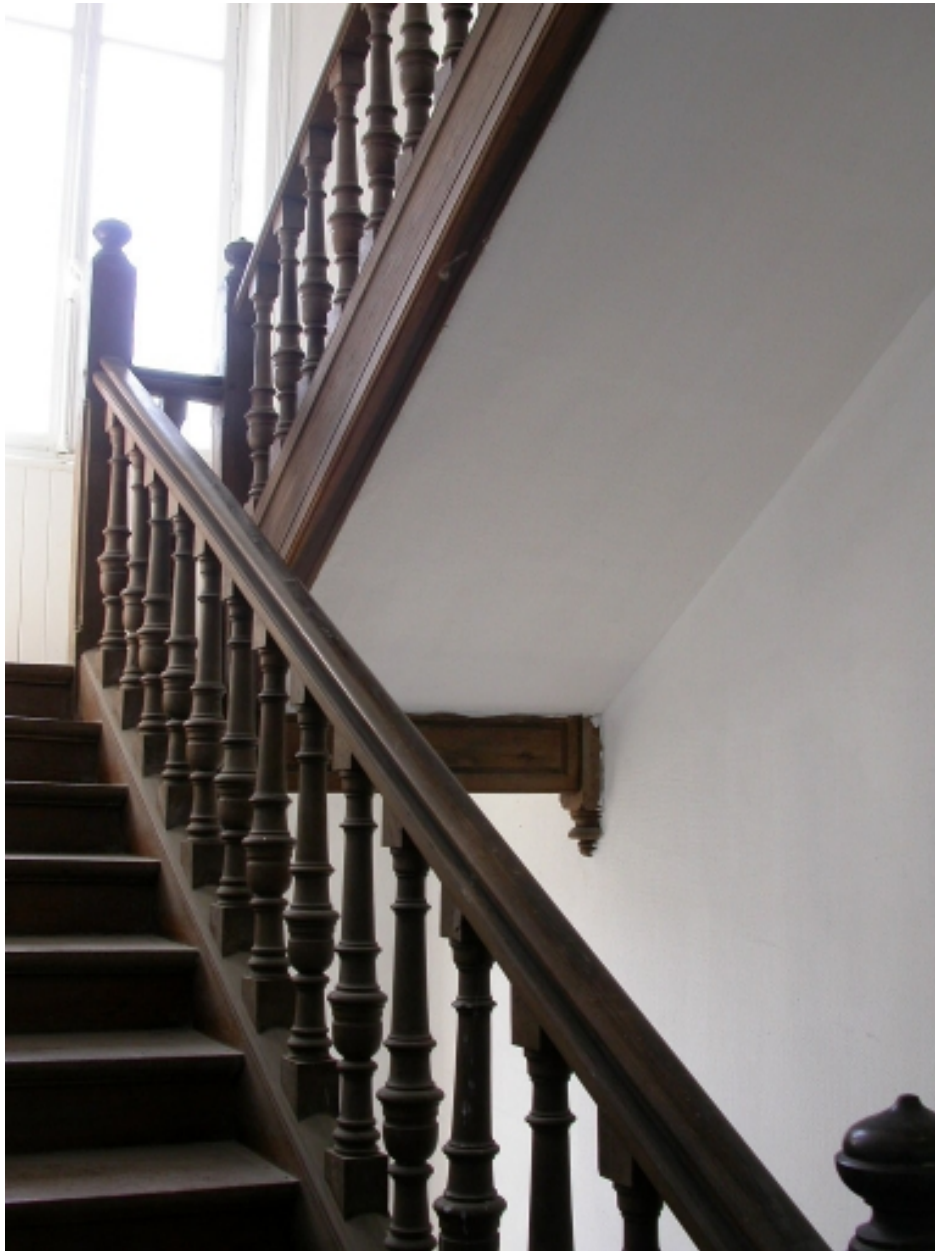
L'escalier à balustres
