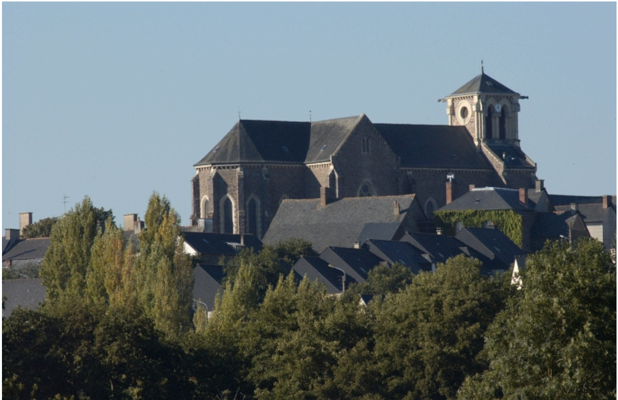
Vue de situation nord-est
