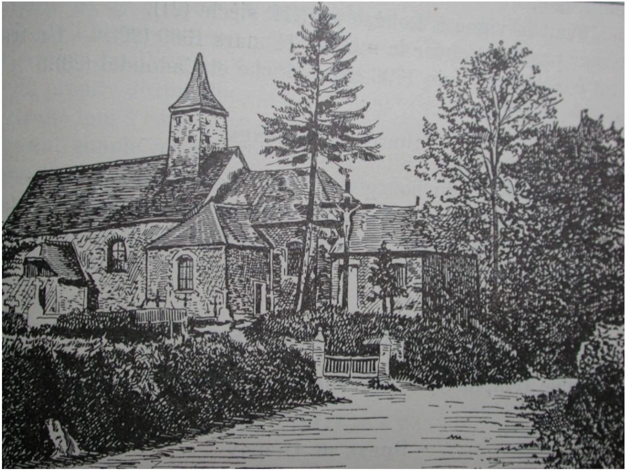
L'église détruite à Saint-André
