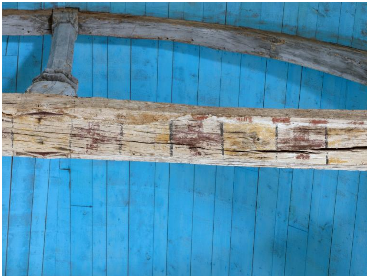
Charpente peinte de la nef ; entrain à décor de croix et de fleurs, détail
