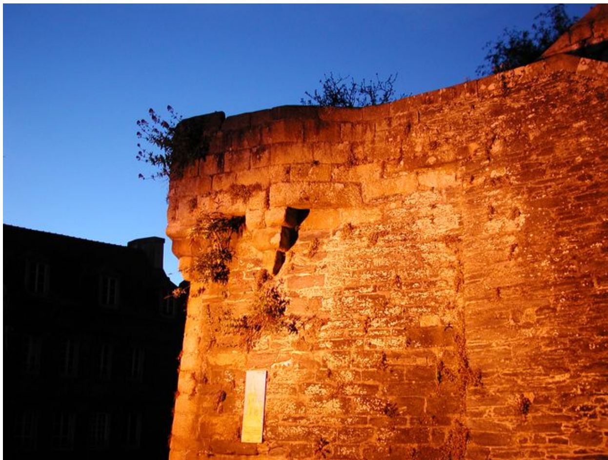
Vue de détail du parapet avec ses mâchicoulis bretons (état en 2002)
