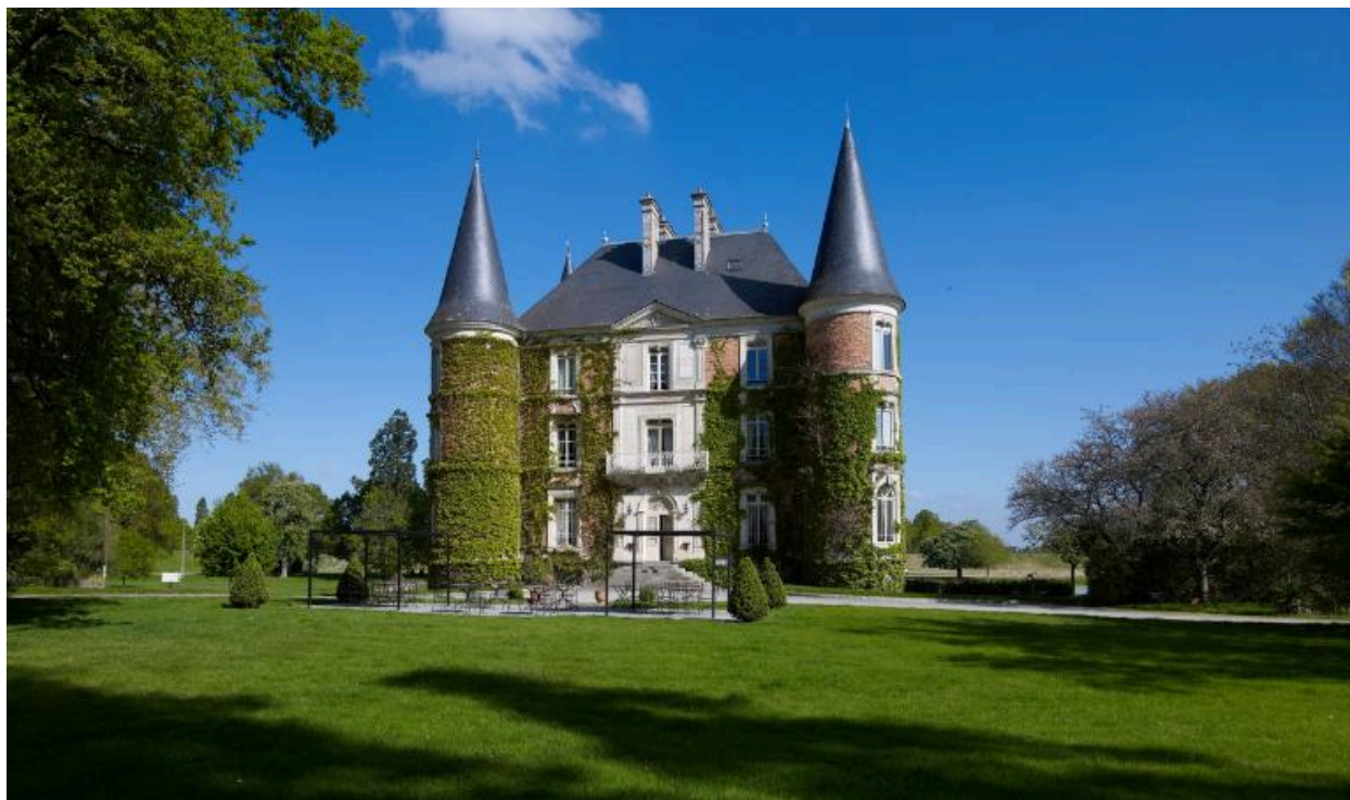
Vue générale de la façade sud
