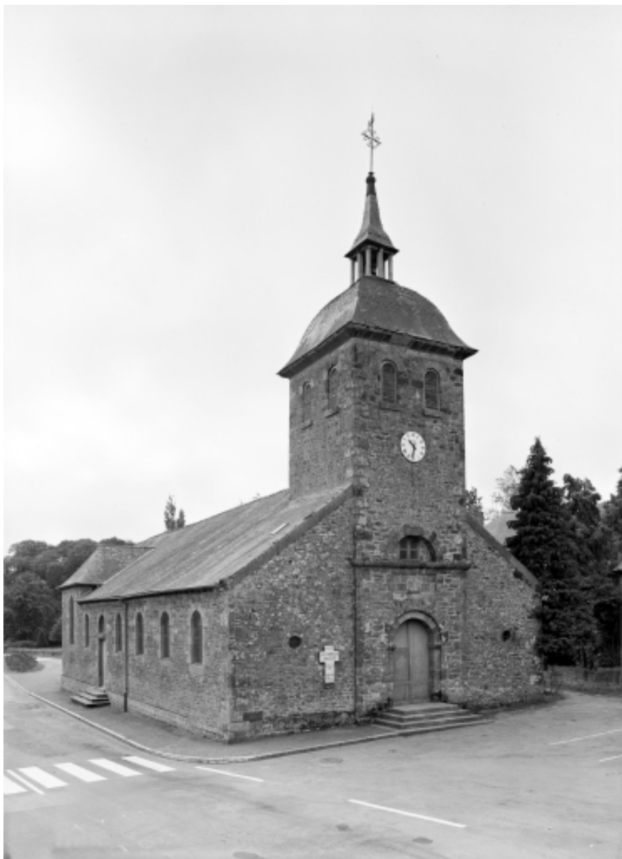
Elévation Nord-Ouest : vue générale
