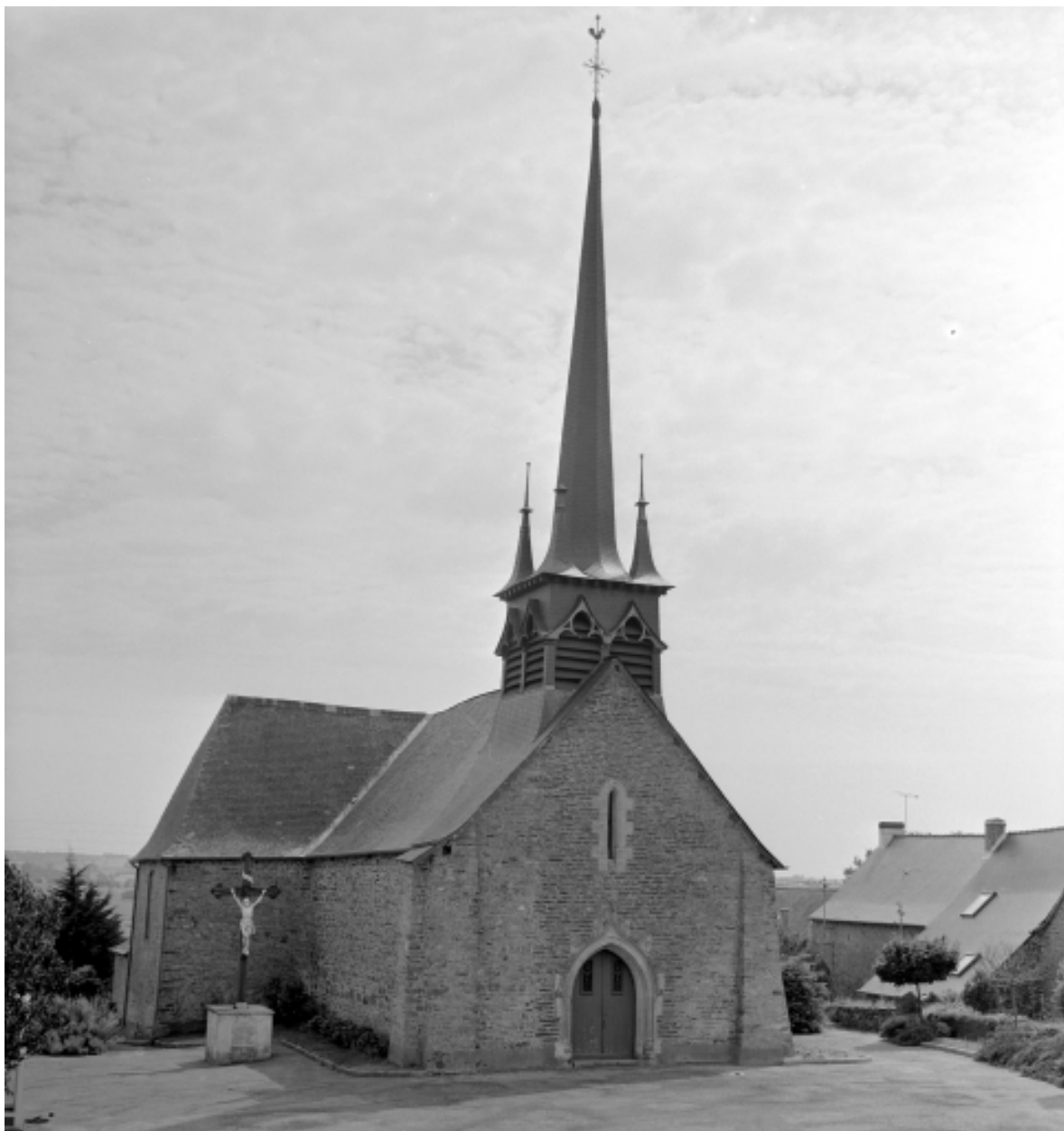
Elévation ouest : vue générale
