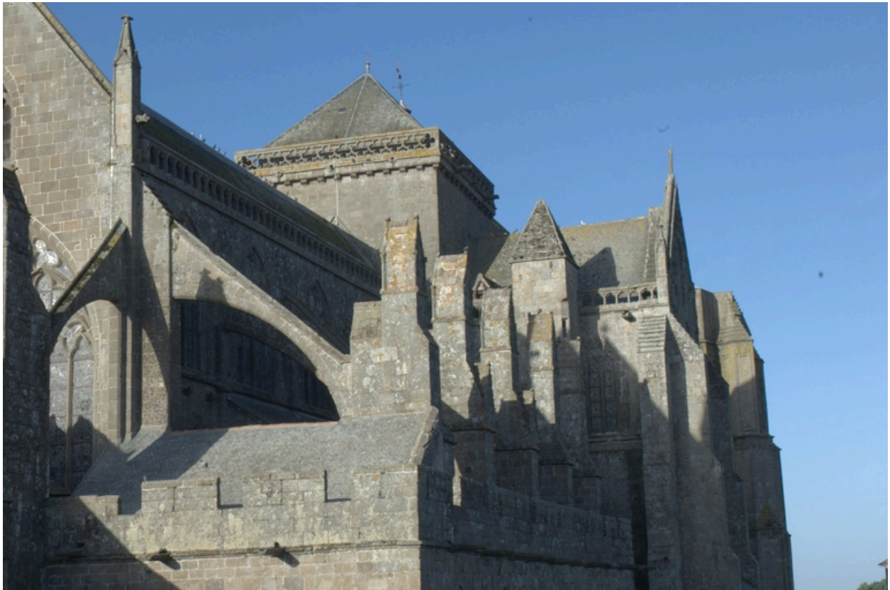
Enfilade des arcs-boutants du choeur côté nord
