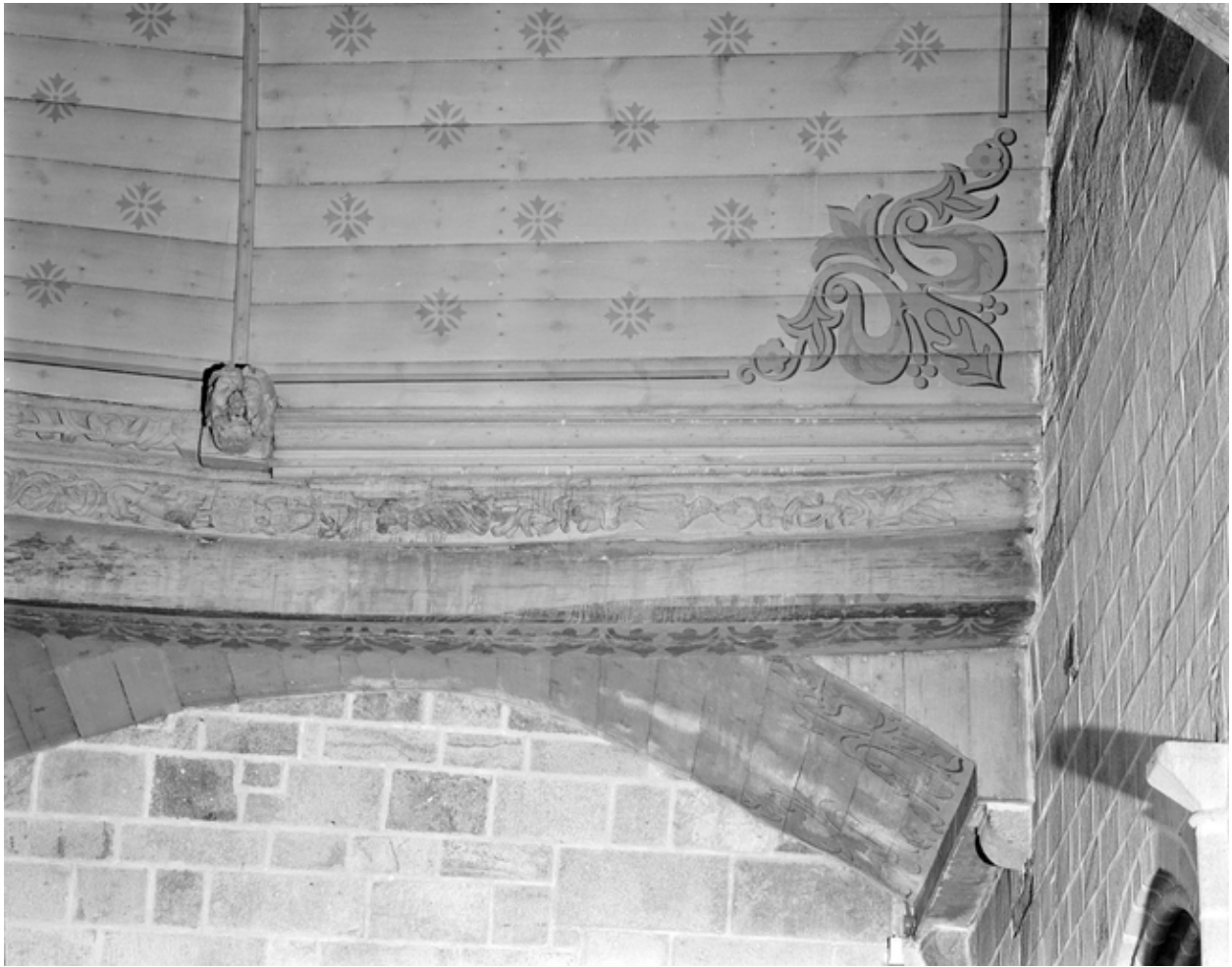
Sablère n°2, bas-côté sud, mur ouest, partie droite
