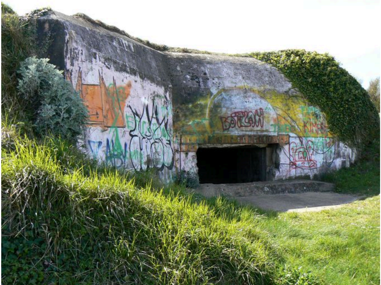
Vue générale de la casemate donnant sur la plage des Grands-Sables
