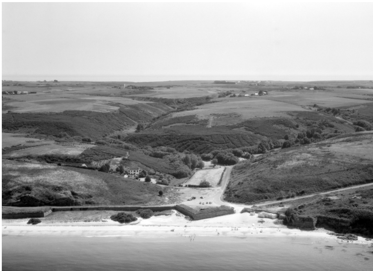
Vue aérienne prise du nord-est, partie est
