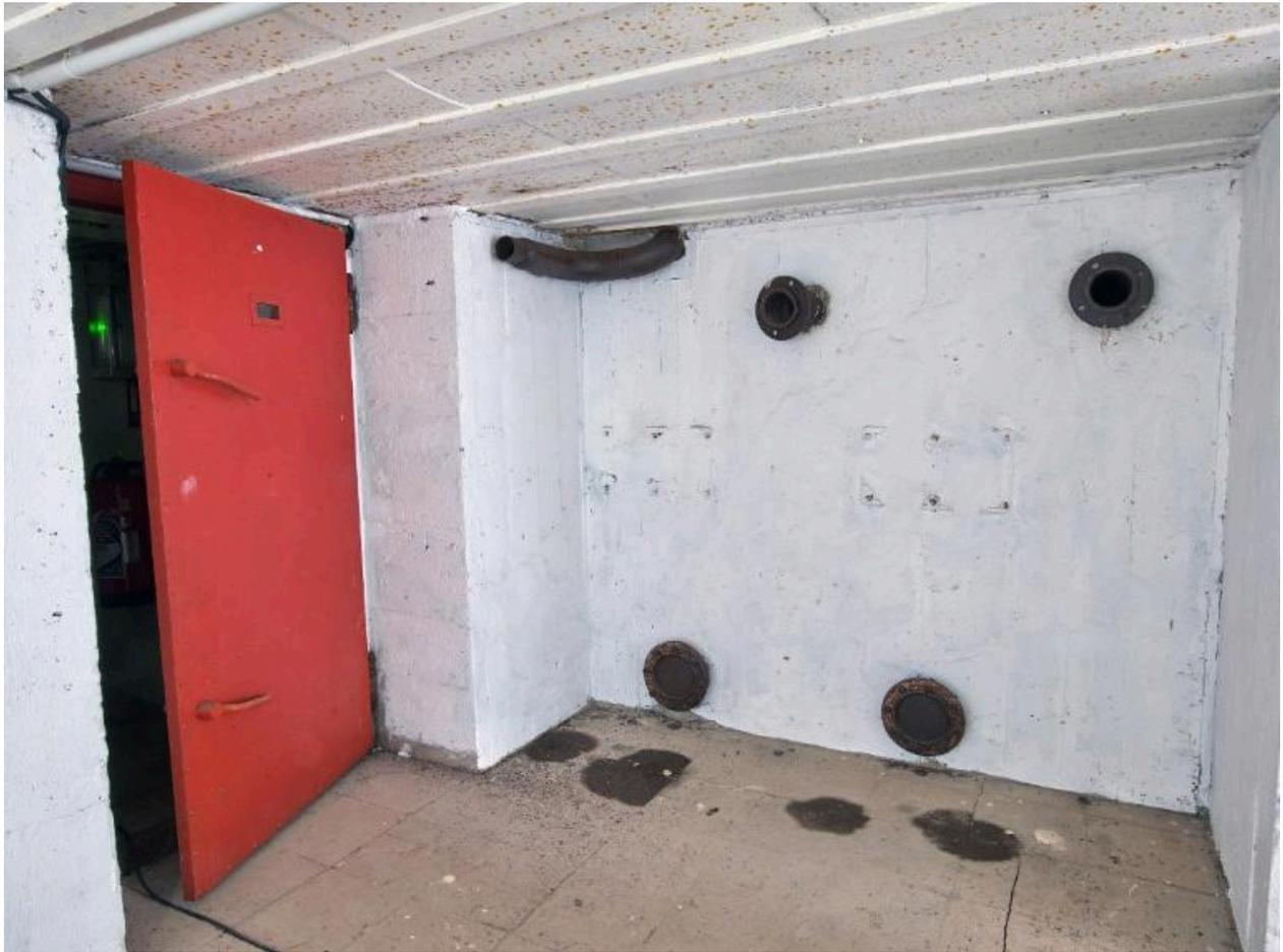
Vue de l'emplacement du système de ventilation : arrivées et prises d'air pour deux ventilateurs (leurs fixations sont visibles sur le mur)
