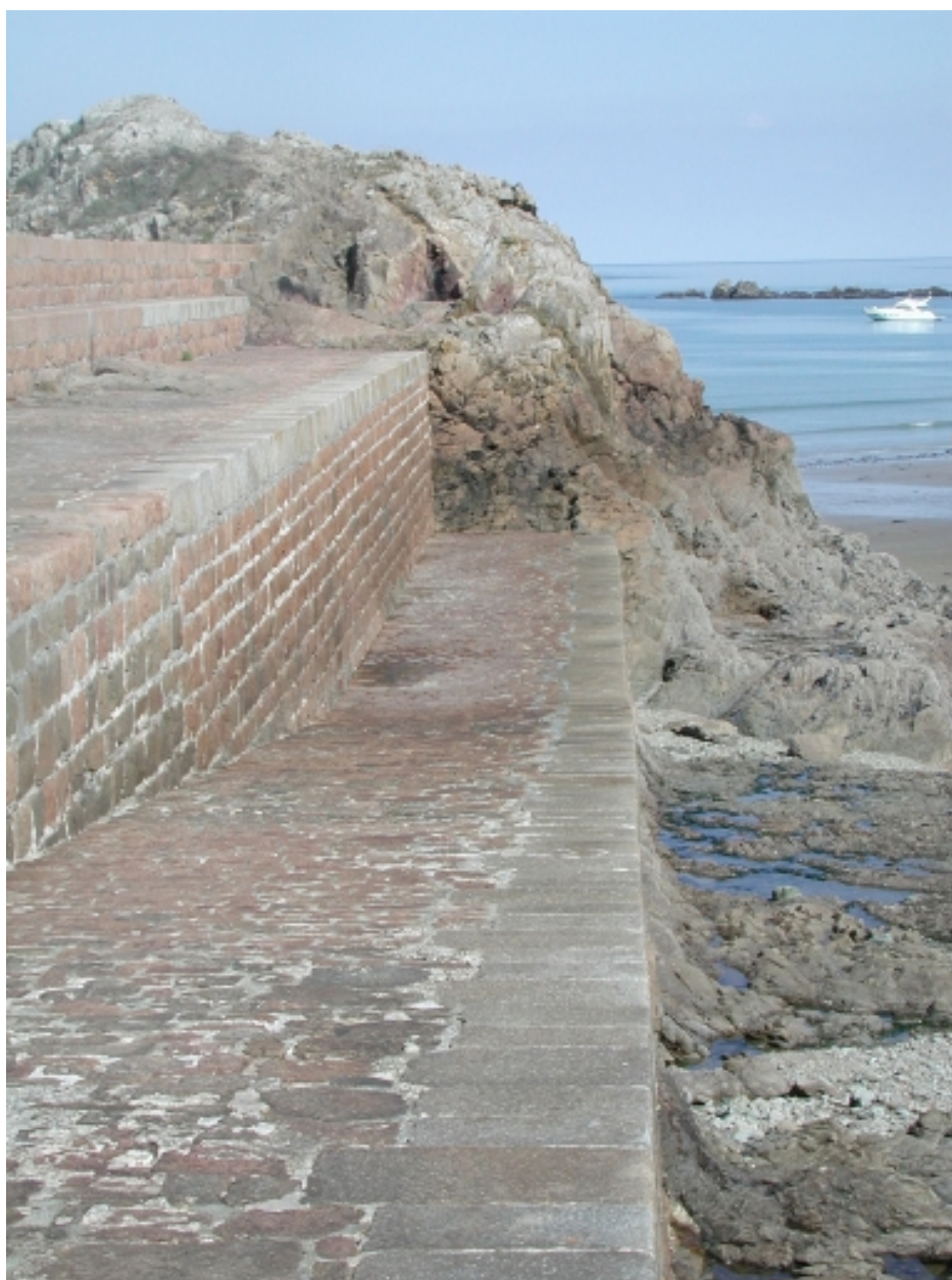
Détail de la maçonnerie en moellons smillés et hourdés
