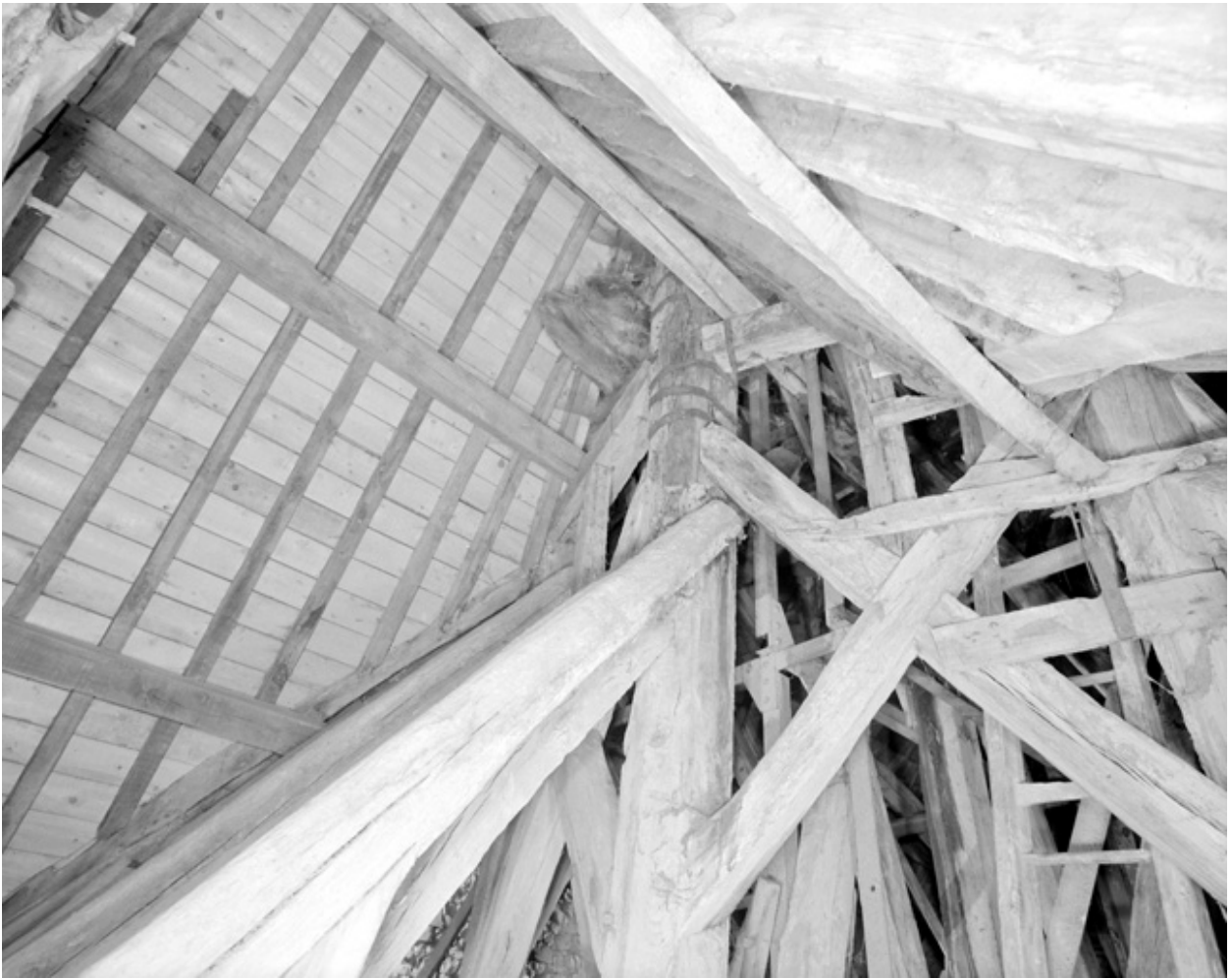
Clocher, combles : détail de la charpente
