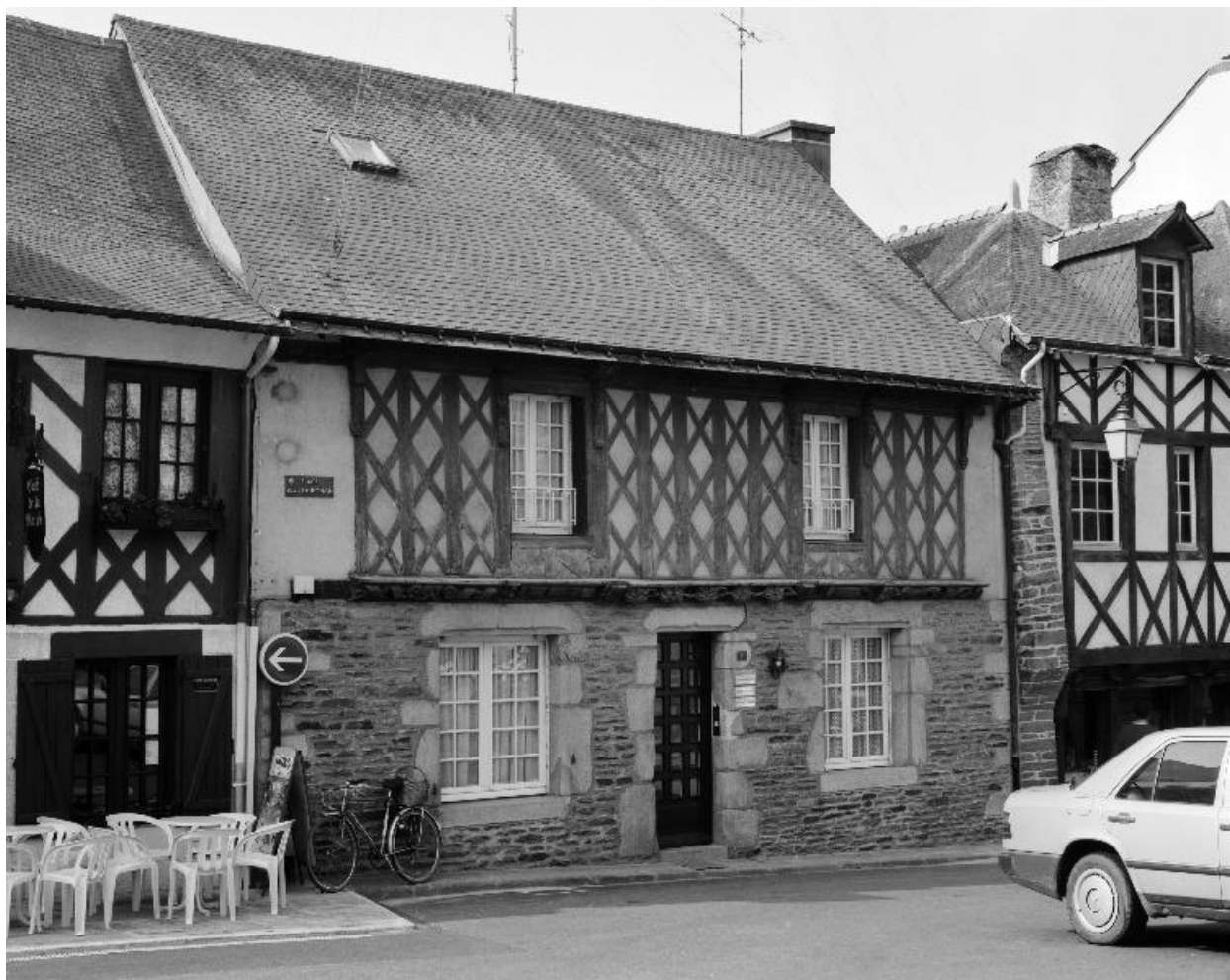
Maison : élévation nord (état en 1992)
