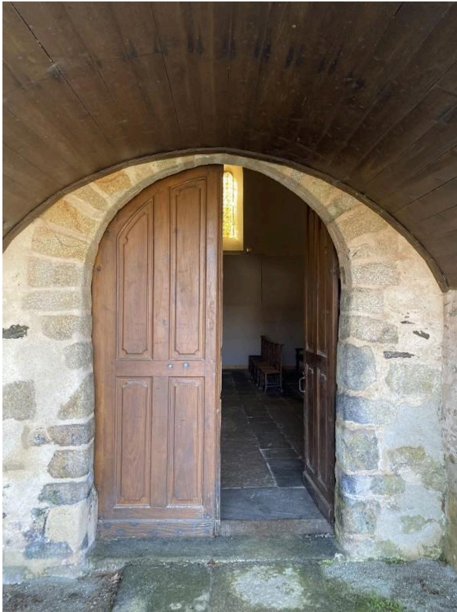
Porte d'entrée, détail
