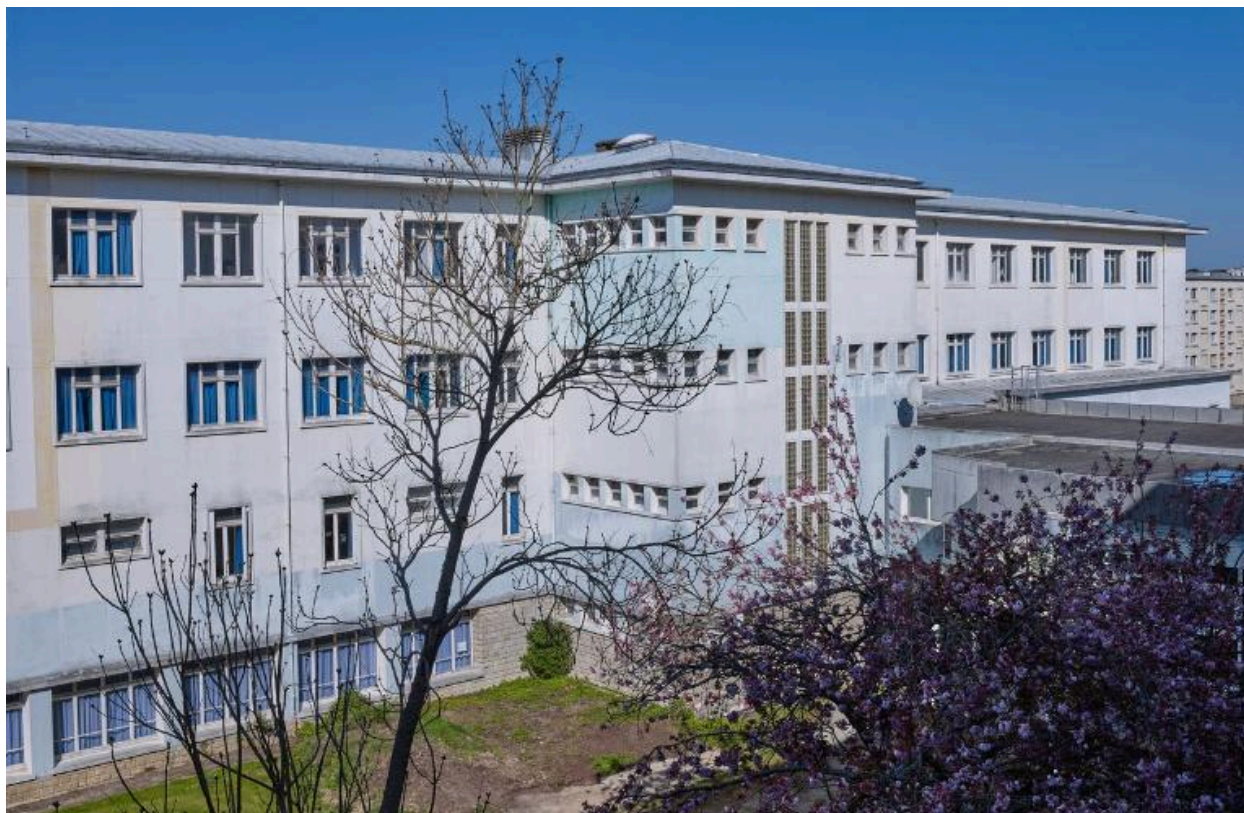
Internat B, façade est (J-B. Mathon, architecte). A droite, vue partielle du CDI (Guénolé Chateau, architecte, 1994).
